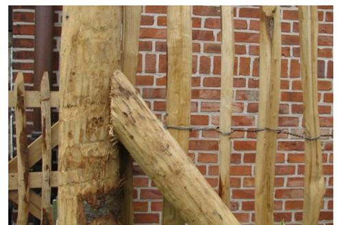
Wir empfehlen für die Verwendung der Staketenzäune den Einsatz von diagonalen Stützpfehlen, die Sie, wie auf eines der oberen Fotos zu sehen, in den Zaun mit einarbeiten sollten. Diese halten den Zaun dauerhaft auf Spannung und verhindert ein Zusammenziehen des Zaunes.
